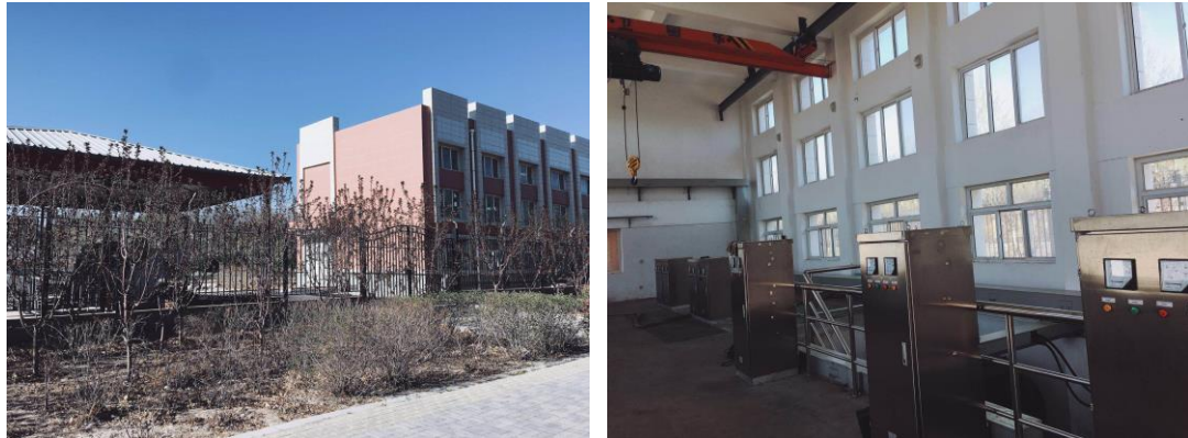
图 2-70 北泵站现状图
