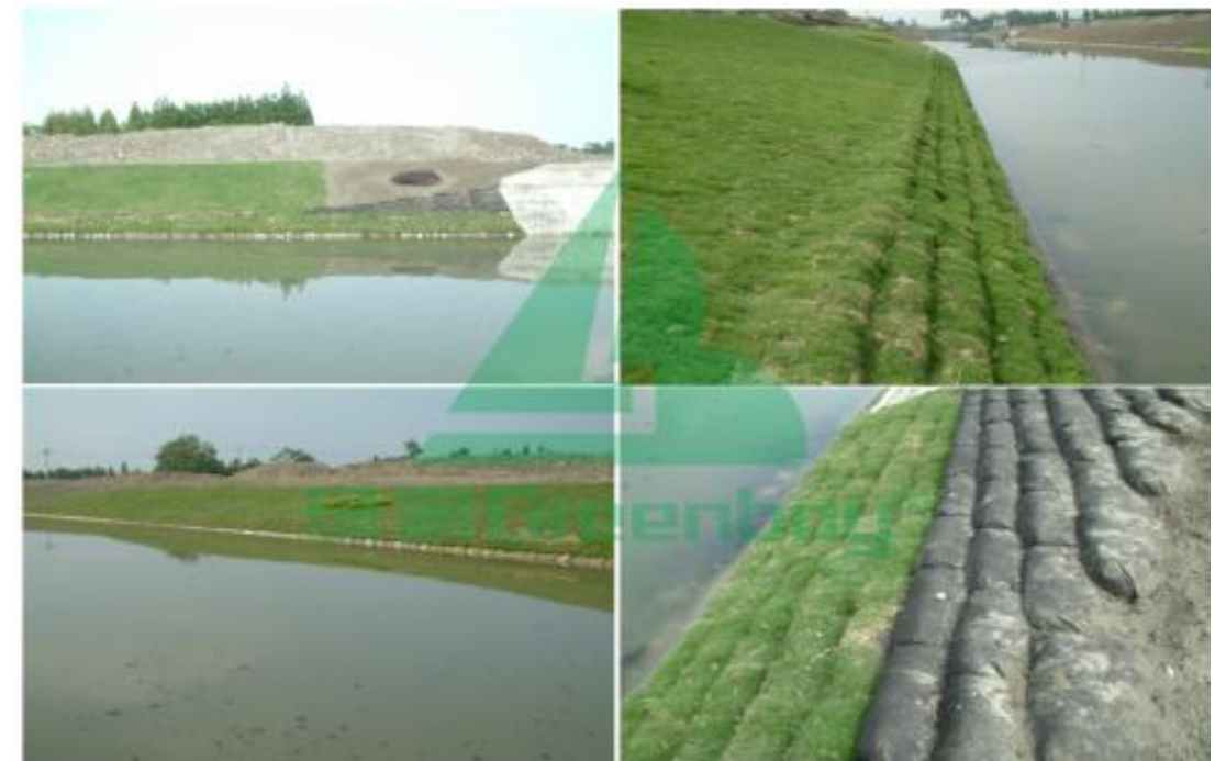
图 10-29 生态袋生态护坡
