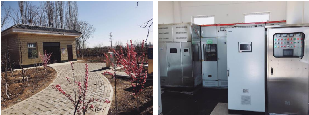
图 2-73 秦渠北一体化泵站现状图
