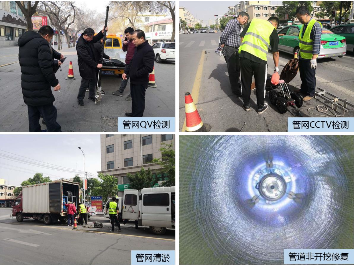
图 7-4 管网诊断与修复
