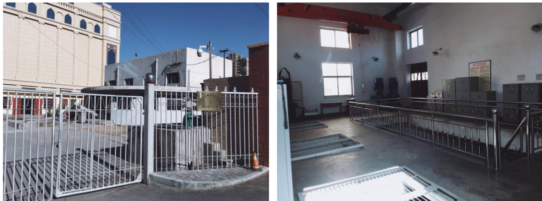
图 2-72 西泵站现状图
