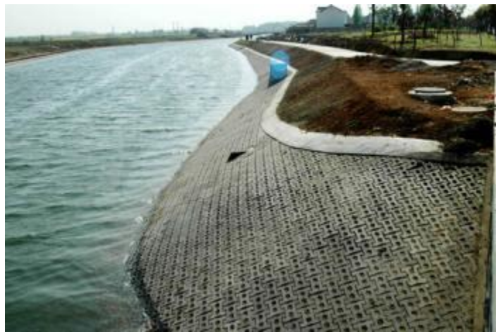
图 10-27 铰接式砼块护坡
