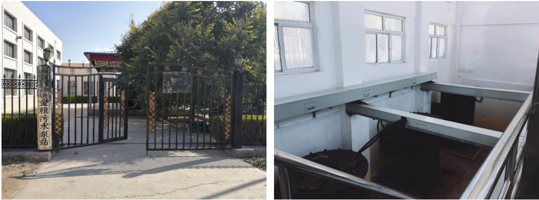
图 2-76 金积泵站现状图
