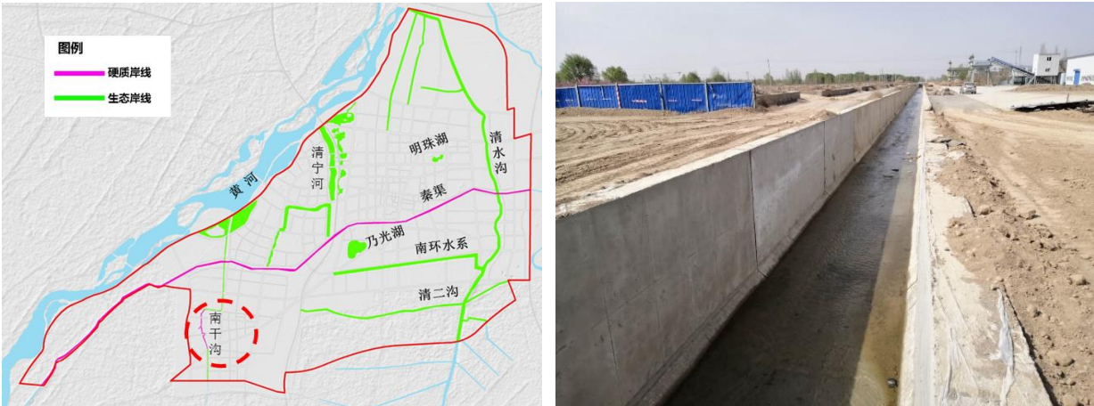
图 4-16 南干沟局部岸线已经硬化（三面光）
