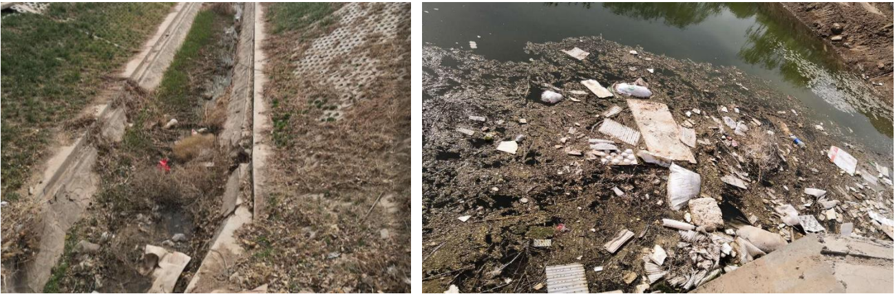
图 4-15 局部河道及岸线缺少维护（存在垃圾和漂浮物）
