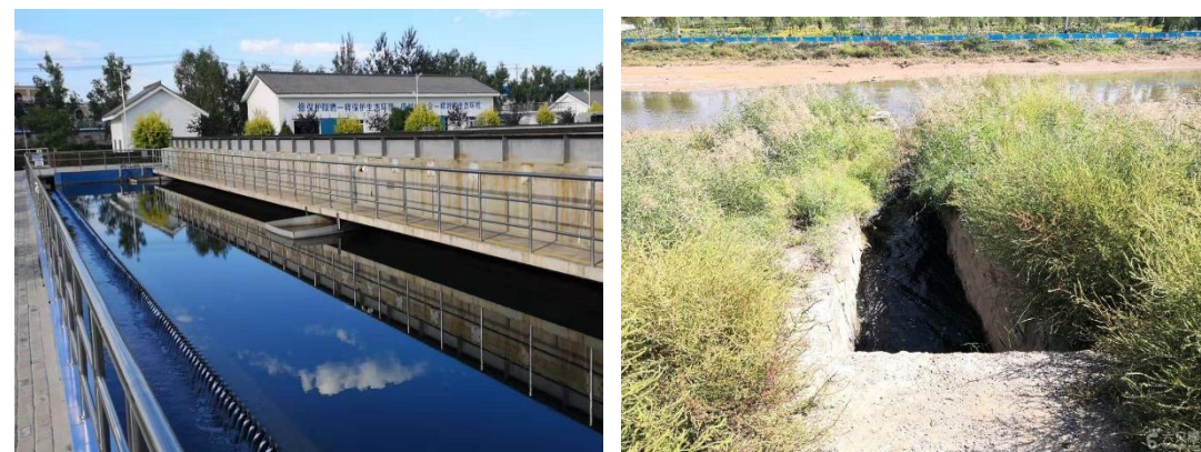
图 2-67 第二污水厂现状图
